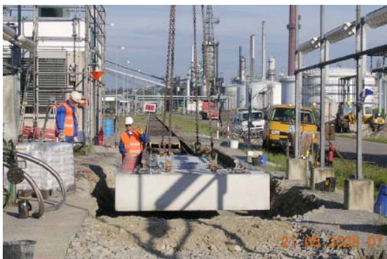
Einheben eines Gleiswaagensegmentes
