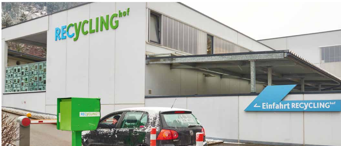
Bild 1: Wertstoffhöfe haben häufig Öffnungszeiten, die sich nicht mit gängigen Arbeitszeiten vereinbaren lassen. Wohin also mit dem Müll nach Dienstschluss? Der Recyclinghof im österreichischen Kufstein beweist mit erweiterten Öffnungszeiten und einem modernen Selbstbedienkonzept Bürgernähe und Kundenfreundlichkeit.
