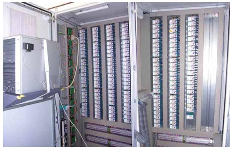
**Abb. 6: Das Innenleben des Schaltschranks im Messtechnik- und Steuerraum mit über 160 Gleichspannungsmessverstärkern, und dem Rechner, der auch A/D-Wandler enthält**
